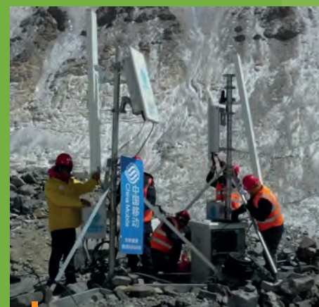
Budowa stacji 5G na Mount Evereście
